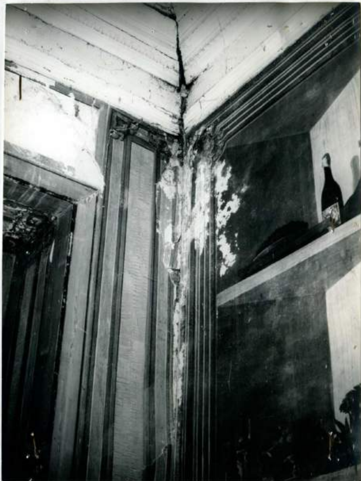
Pintura "tromp-l'oeil" no salão de jantar do prédio da rua Barão de Tinguá nº - Vassouras - Estado do R.J. (Antiga residência do Barão de Itambé, pai do Barão de Vassouras.)
