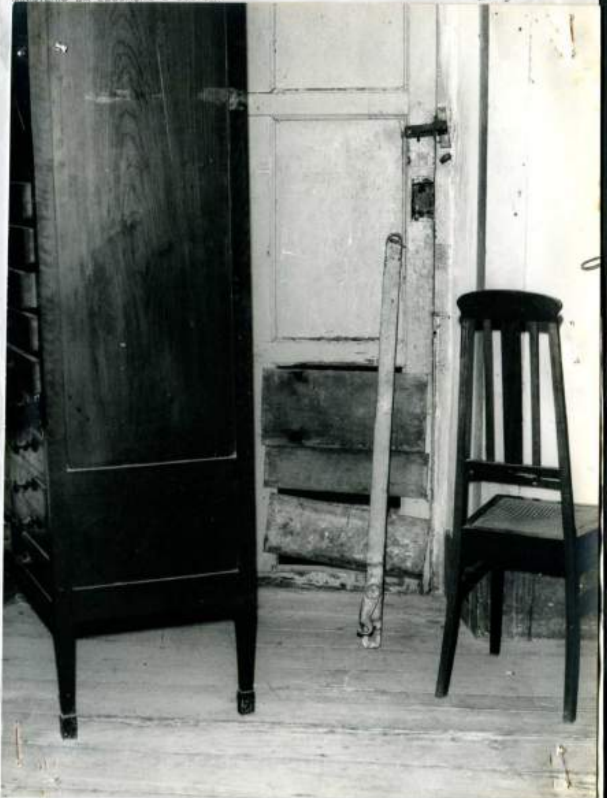
Interior do prédio nº 3 da Rua Barão do Tinguá - Vassouras - E.R.J. (Antiga residência do Barão de Itambé, pai do Barão de Vassou- ras)
